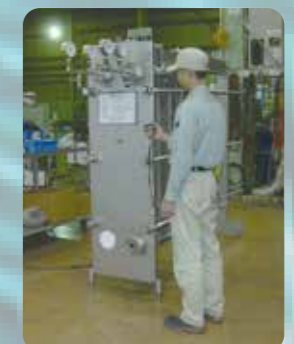
気密テスト 完成検査
