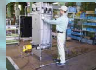
組み立て 締め付け
